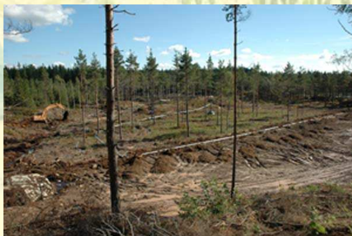
Rörsystemet till snökanonanläggningen placeras ut. Foto: Bengt Erlandsson
